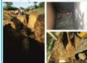
Empalme y cambio de trayectoria en tubería de 12" y 4" HG en el Puente de Cacique. 1era etapa (2, 3, 4 y 5 febrero 2017) y 2da etapa (22, 25, 28 y 29 de septiembre).
