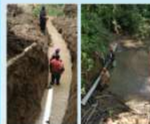
Rehabilitación de tubería de 8" Pvc. Mejora del servicio en El Palmar, Cayetano Germosén. (20 junio 2017)
