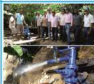
Instalación de sistema y bomba en el pozo #1, Gaspar Hernández. (26 septiembre 2017)
