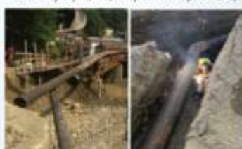
Empalme y cambio de trayectoria en tubería de 12" y 4" HG en el Puente de Cacique. 1era etapa (2, 3, 4 y 5 febrero 2017) y 2da etapa (22, 25, 28 y 29 de septiembre).
