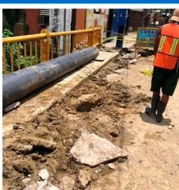
La brigada de Operaciones y mantenimiento de CORAAMOCA realizó sustitución y cambio de trayectoria en tubería de 16" y 4" en hierro en el puente del Caimito de la Rosario Moca, buscando mejorar la distribución del servicio de agua, evitando la pérdida física de agua generada por las perforaciones en la tubería a sustituir.
